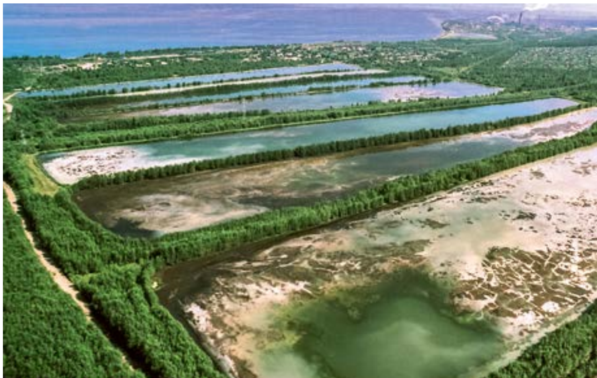
Справа: отстойники-шламонакопители Байкальского целлюлозно-бумажного комбината.
